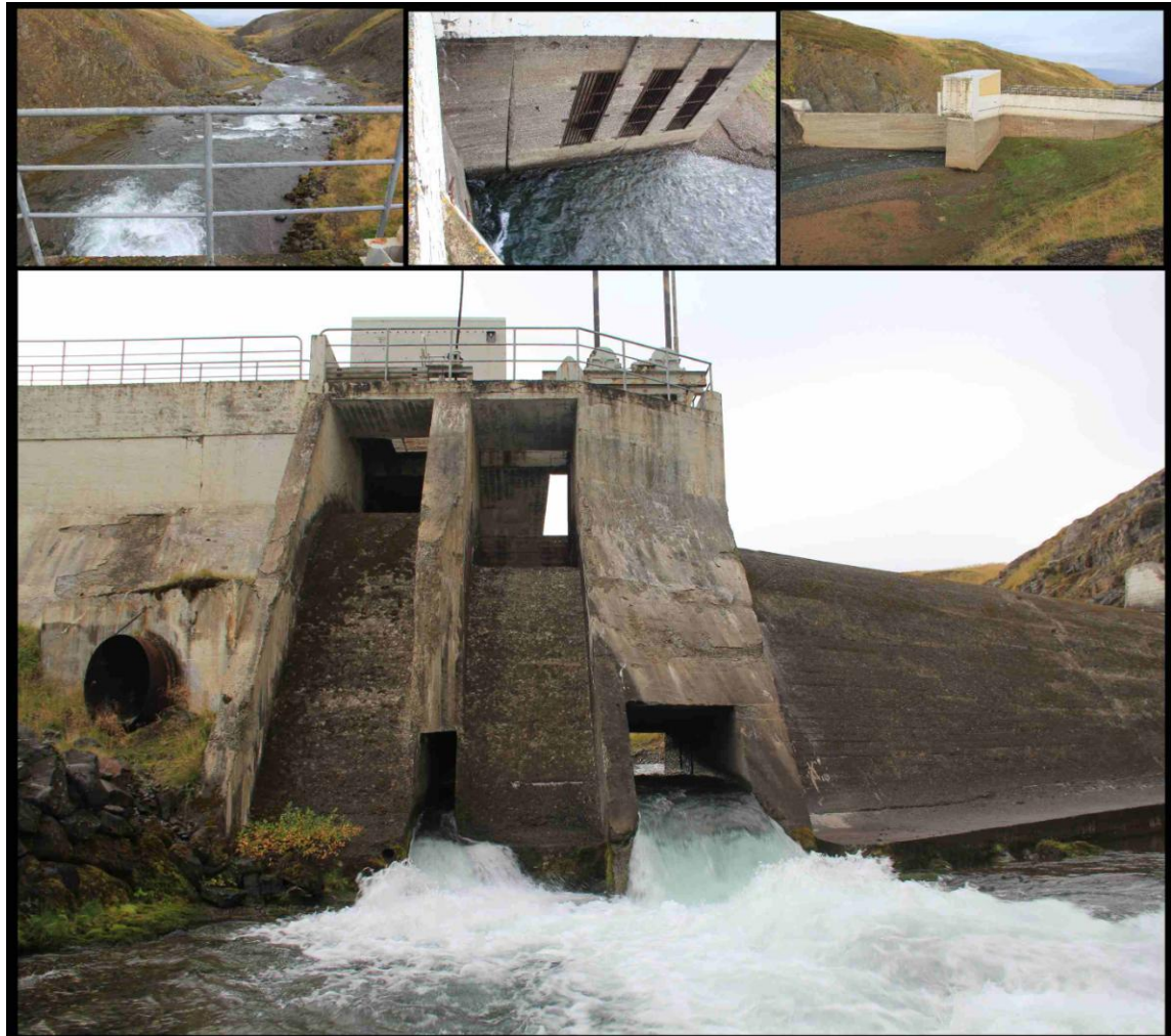
Myndin sýnir stíflumannvirkið ofan- og neðanvert og nánasta umhverfi þess.
